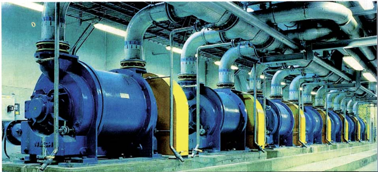
Bombas Nash en serie para una instalación de vacío.
